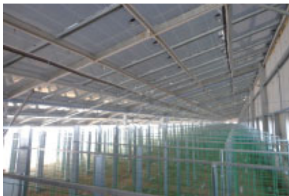
图 4 全遮光的光伏太阳能温室与食用菌栽培架
